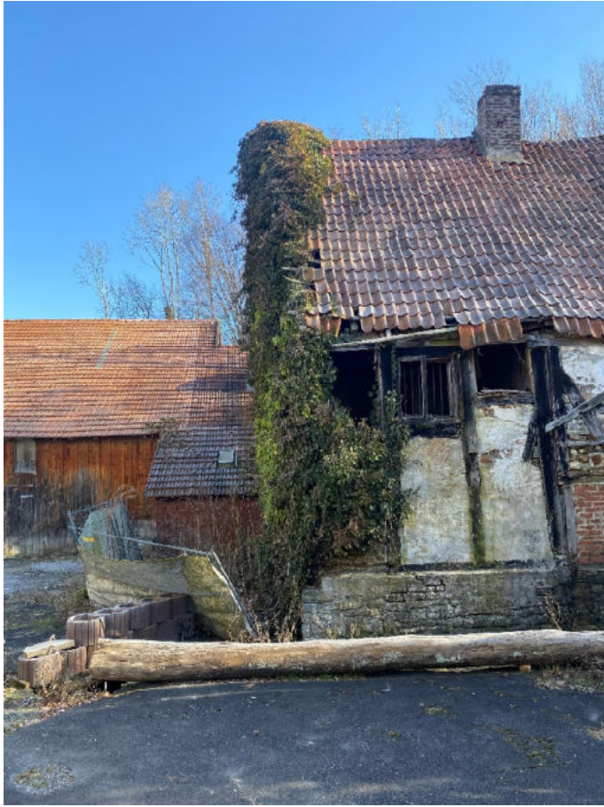
Bild 9: Wasserseite, stark zum Hof geneigter Giebel (Südseite)
