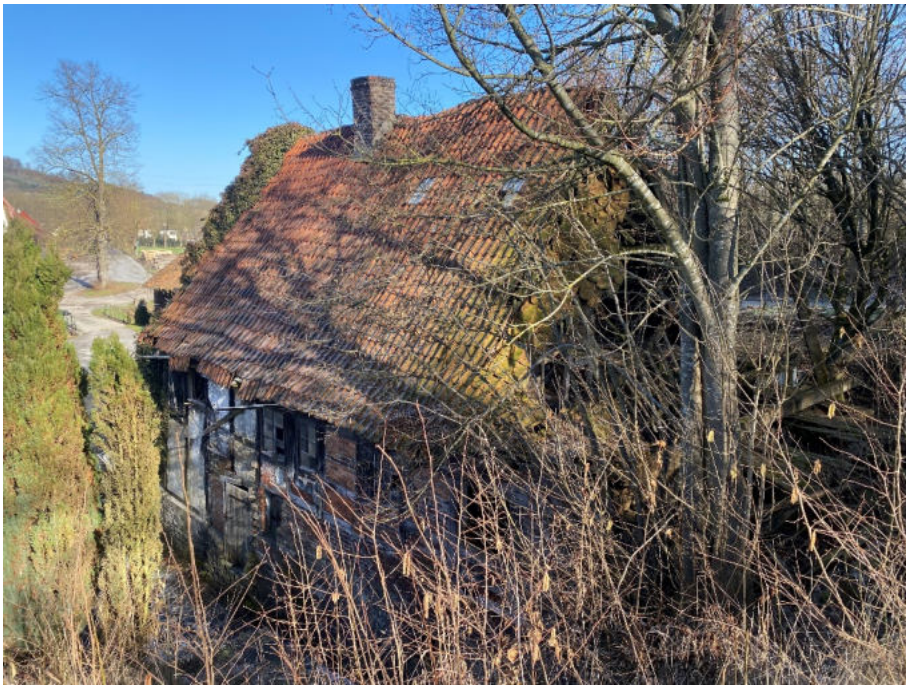
Bild 22: Wasser-/ Stauseite, vom First aus schiebende Dacheindeckung, geneigter Kaminkopf (Ostseite)
