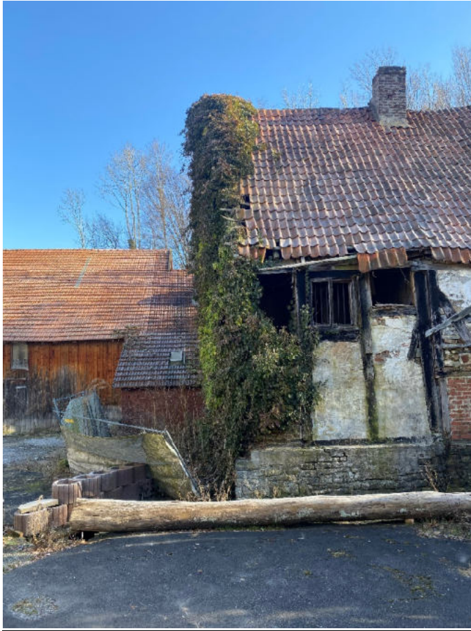
Bild 9: Wasserseite, stark zum Hof geneigter Giebel (Südseite)
